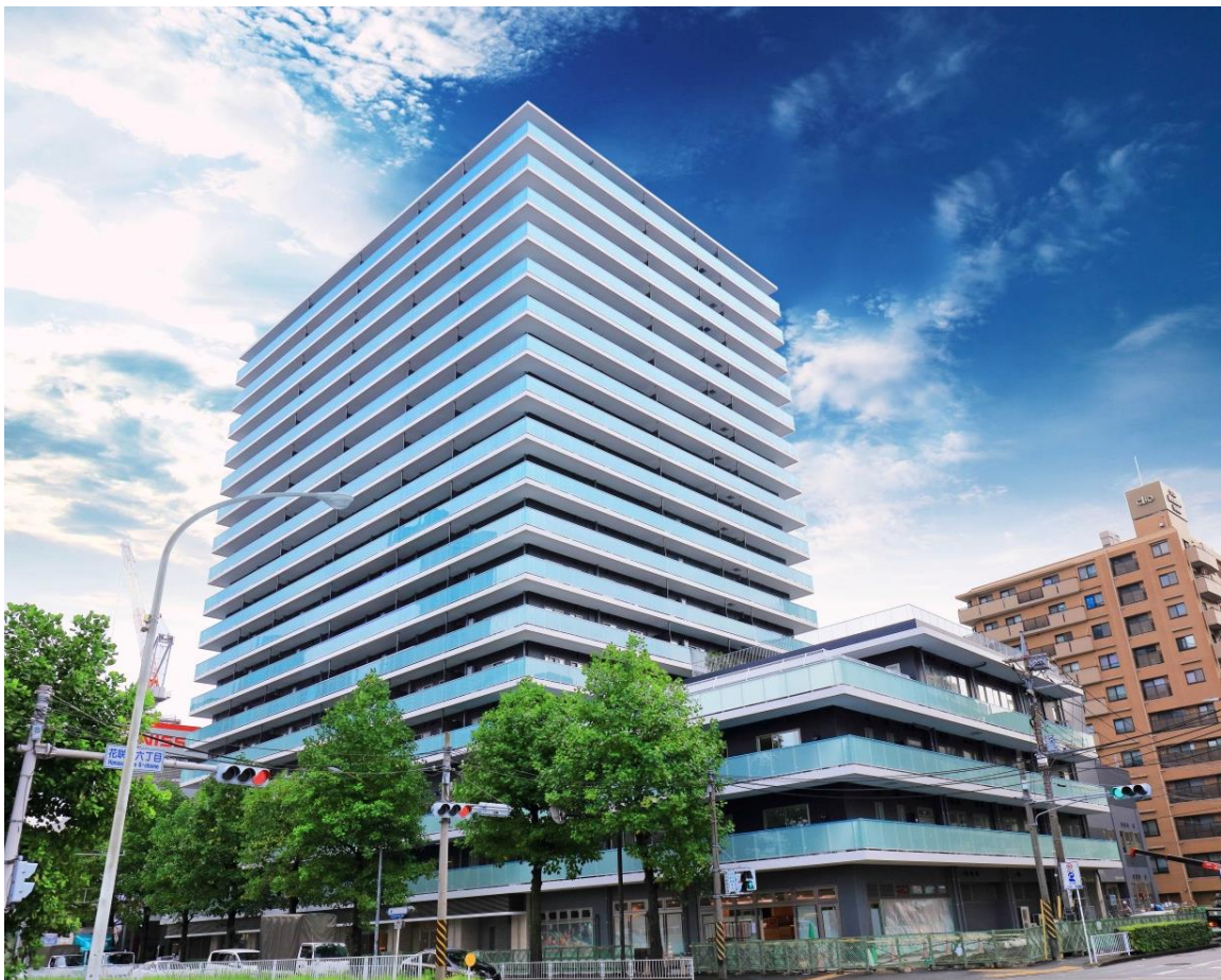
(横浜 MID ベースタワーレジデンス外観写真)
