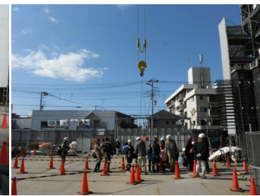
【タワークレーン操作指示体験】
